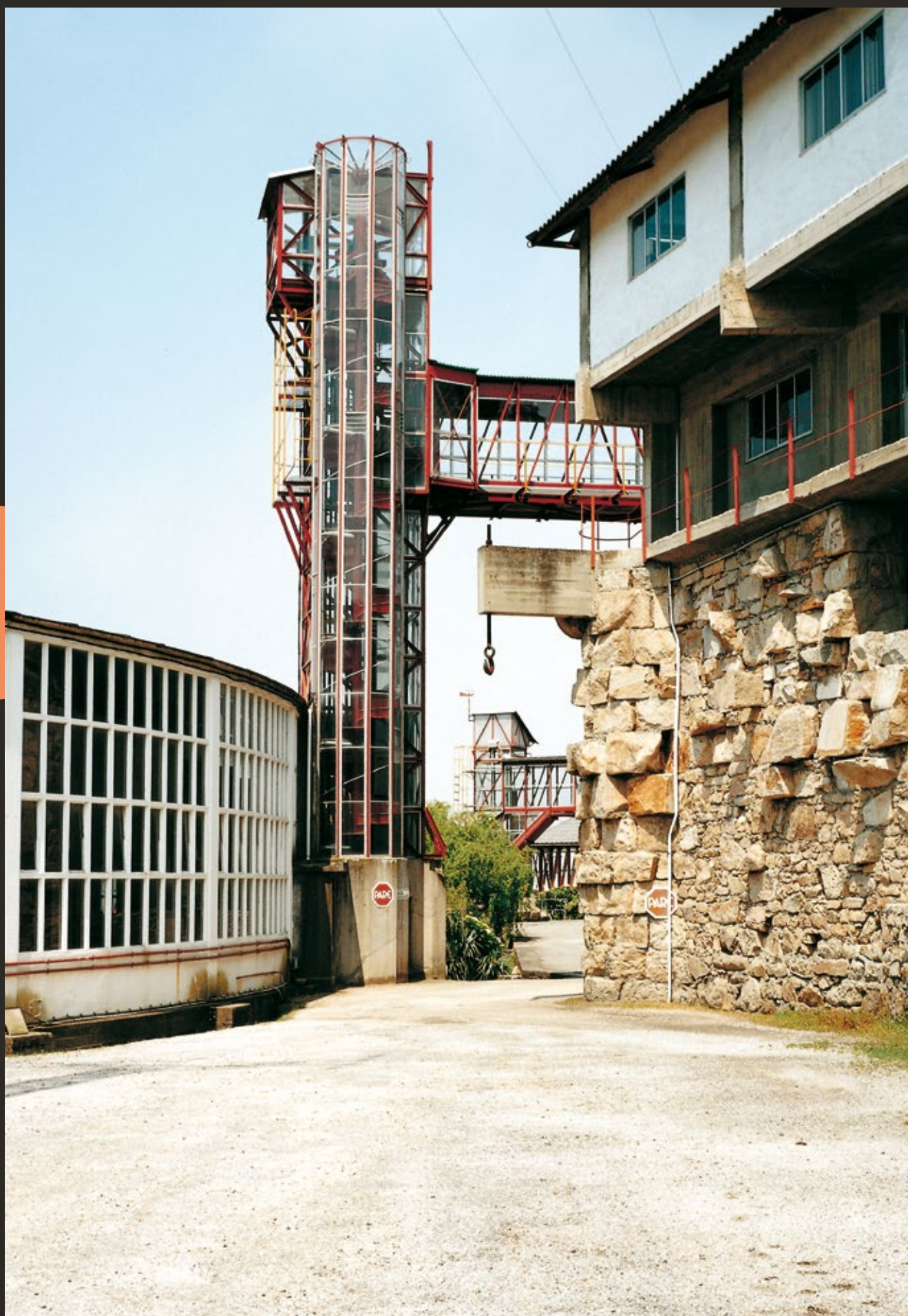
Torre do ascensor que une a planta circular de Sargadelos coa nova nave de produción (Fotografía de Juan Rodríguez)
